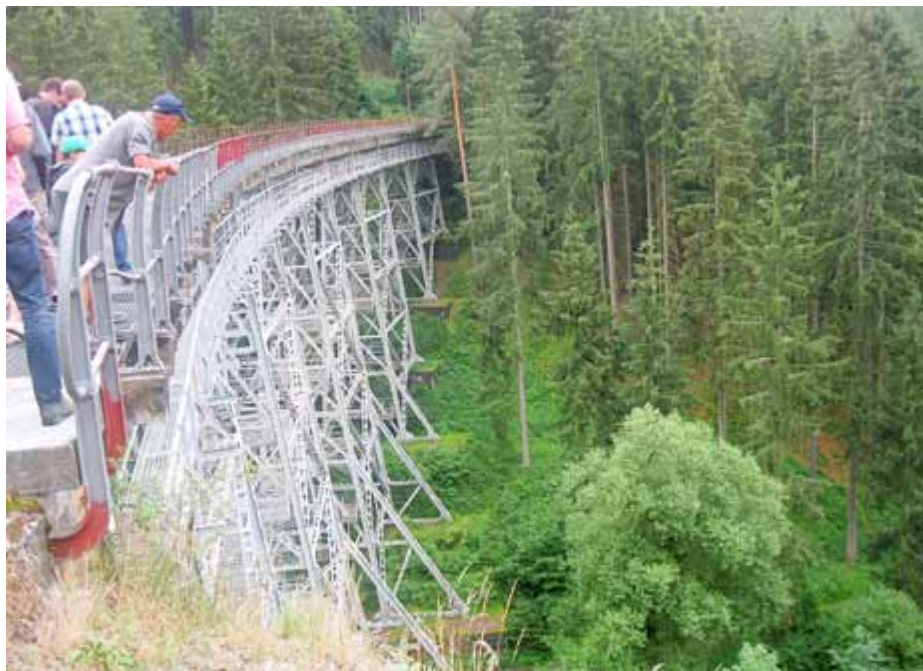
Breitenhainer auf der Ziemestalbrücke
