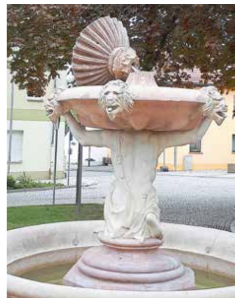
Abgebrochene obere Schale und freiliegende Leitungen
