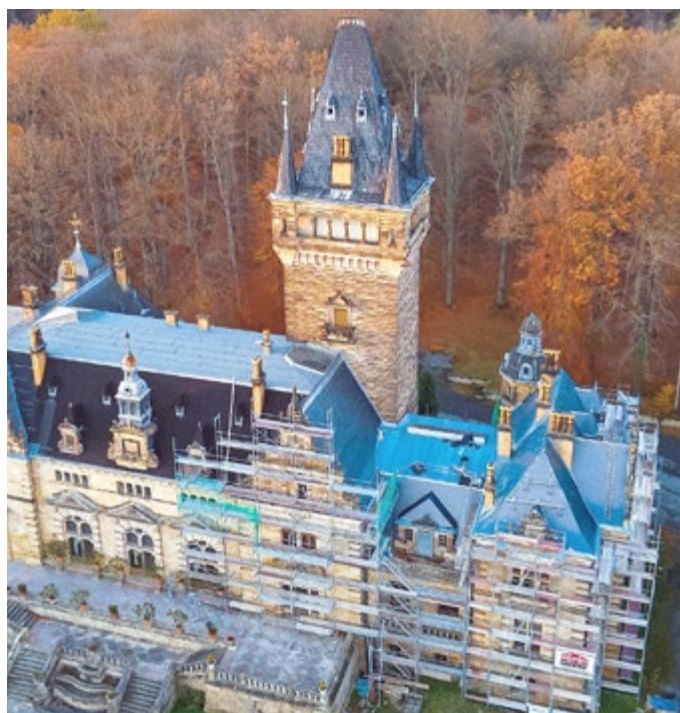
Rechts im Bild der eingerüstete Herzogin-Agnes-Flügel des Schlosses Foto: Meinecke
