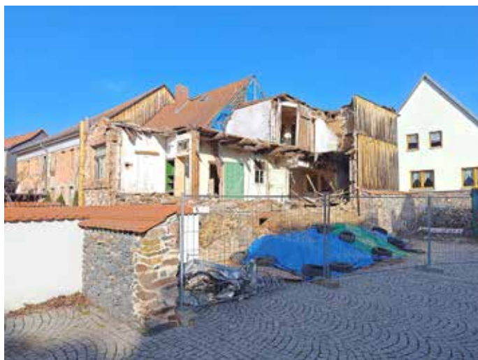
Aktueller Stand der Abbrucharbeiten in der Gerichtsgasse 3
