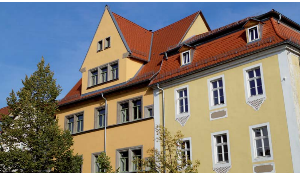
Fassadenansicht Rodaer Straße
