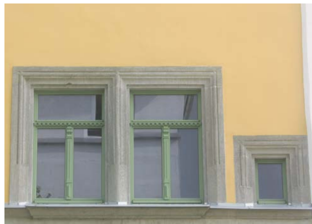
Gelungene Fenstersanierung in der Rodaer Straße
