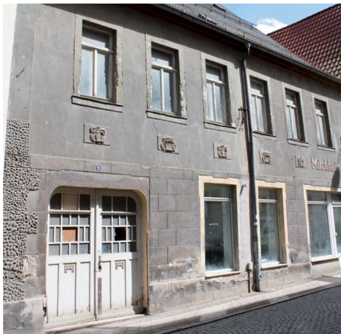
Ausgangssituation vor den Maßnahmen
