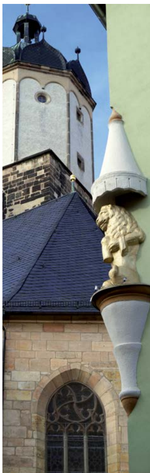
Detail Fassade Ernst-Thälmann-Straße
