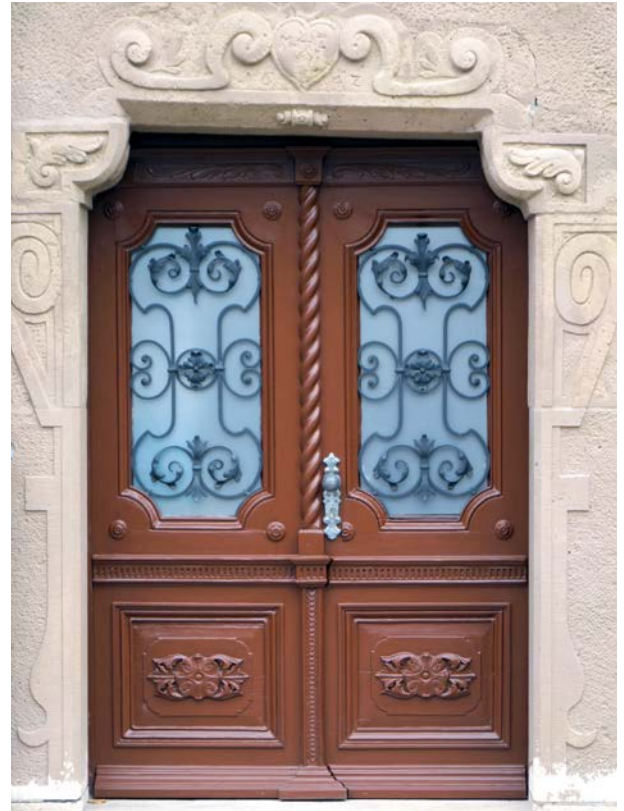
Gelungene Restauration der Eingangstür
