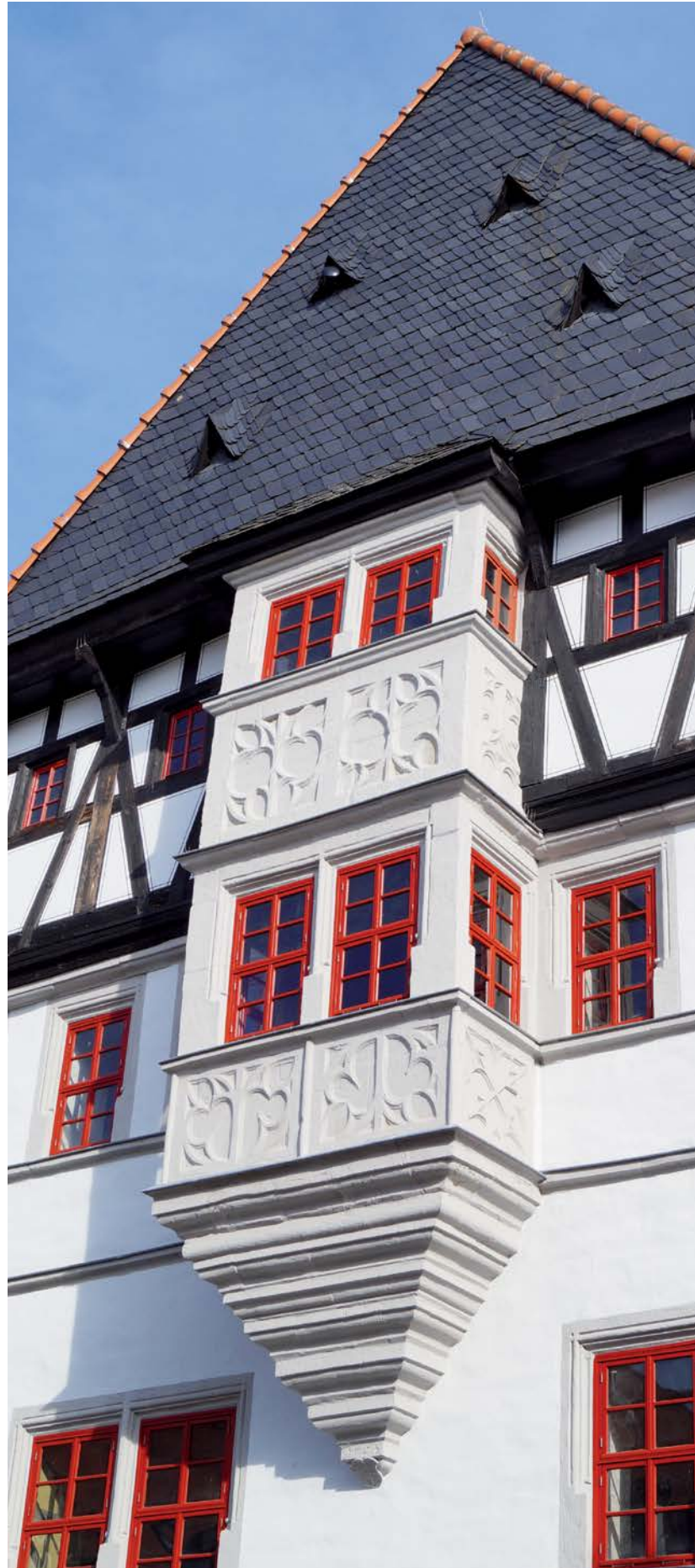
Fassadenausschnitt Lutherhaus in der Rodaer Straße
