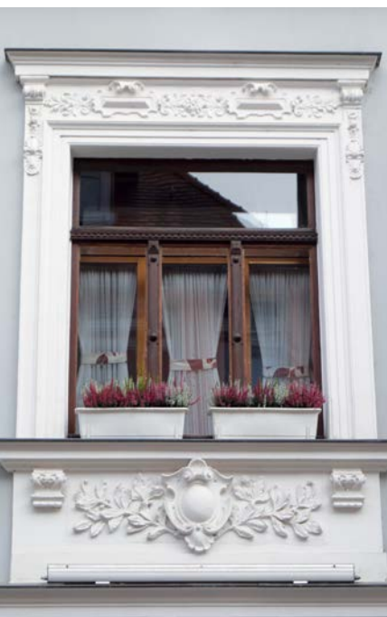
Gelungene Fenstersanierung in der Ernst-Thälmann-Straße
