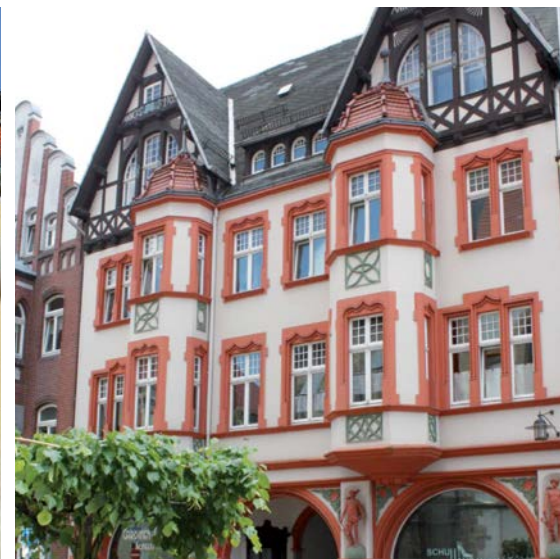
Fassadengestaltung mit Schmuckelementen und Anbauten in der Ernst-Thälmann-Straße
