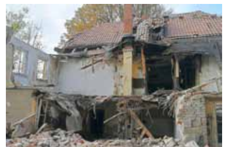
Rückseite des Gebäudes
