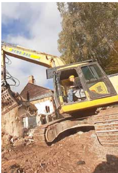
Bürgermeister Ralf Weiße legt selbst beim Abriss Hand an
