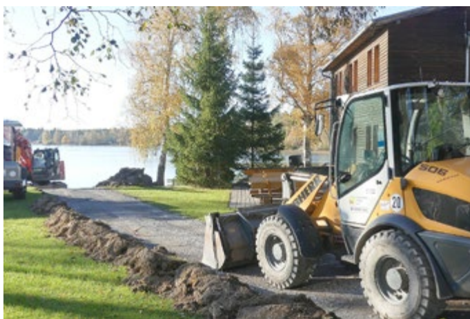
Baustraße an der Jugendherberge Plothen (Foto: Stephan Umbach)
