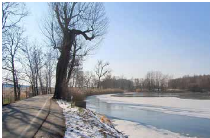
Sicherungsarbeiten am Damm des Genscherodteiches; Foto: Theresia Linke
