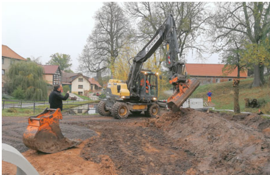
Herr Willing vom Ingenieurbüro wbu erläutert Bürgermeister Weißer die Baumaßnahme
