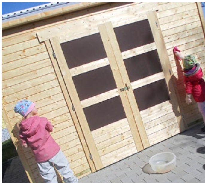
Neues Gartenhaus aufgebaut
