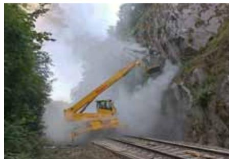
Vorbereitungsarbeiten (22.05.2018): Bohren der Löcher für das Einbetonieren der 2,50 m langen Stahlanker
