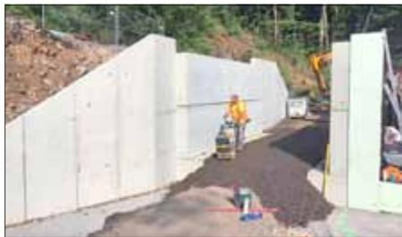
Baufortschritt an der Schlagmühlenbrücke (31.05.2018): Die Widerlager aus Betonfertigteilen, welche ortsnah im Betonwerk Neustadt an der Orla hergestellt wurden, wurden mit dem Kran gesetzt.
