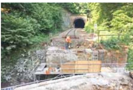
An der Harrasmühlenbrücke erfolgen Ende Mai die Vorbereitungsarbeiten an den Widerlagern für den neuen Überbau.
