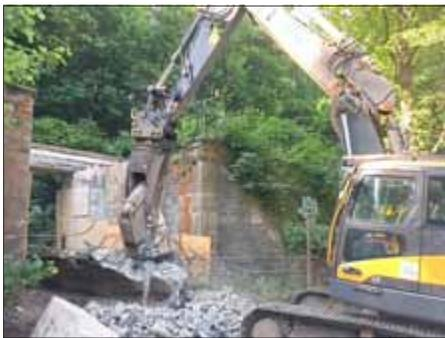
Hier werden die Brückenteile mit einem 20 t-Bagger zerkleinert.
