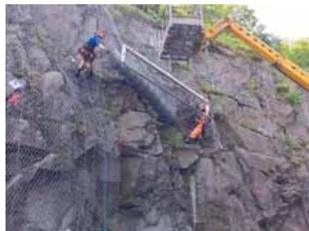
Ende Mai: Sicherungsarbeiten im Baubereich - Verspannen der Felswände mit verstärkten Stahlnetzen
