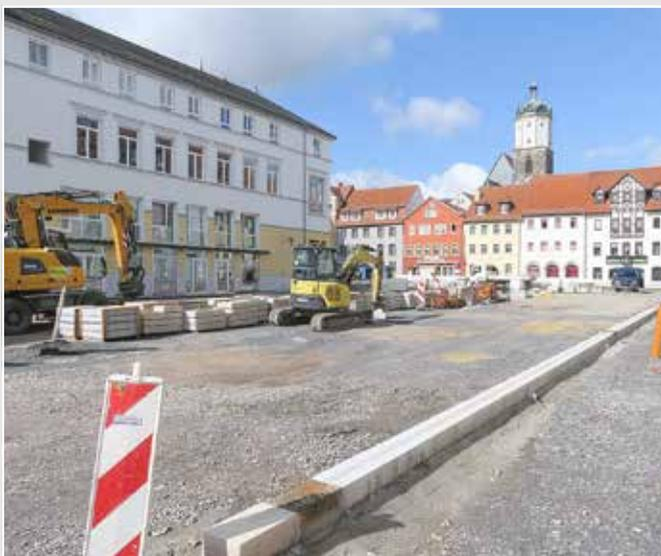
In Vorbereitung der Pflasterarbeiten wurden bereits sämtliche Entwässerungsrinnen und Straßeneinläufe auf dem Marktplatz verlegt. Nun folgt die Setzung der Randsteine für den Wasserlauf und auch der neue Standort der Postdistanzsäule auf dem Marktplatz ist bereits zu erkennen.
