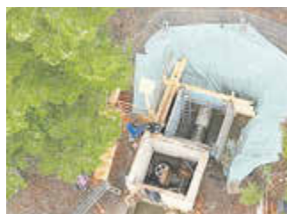
Neuer Teich - Luftbildaufnahme des Schieberhauses
