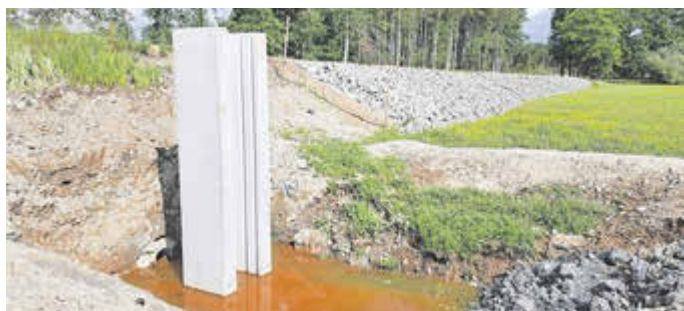
Alter Teich - Bau des überströmbaren Dammes
