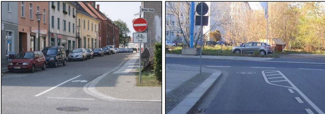
Abb. 34 Einfahrhilfen im Einmündungsbereich freigegebener Einbahnstraßen
