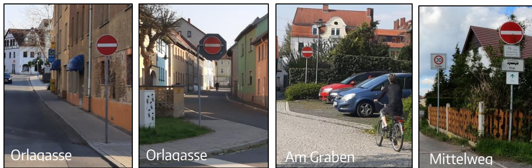
Abb. 8 Bestandssituation im Bereich von Einbahnstraßen
