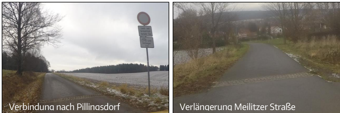
Abb. 12 Beispiele punktuelle Einschränkungen durch Entwässerungsrinnen
