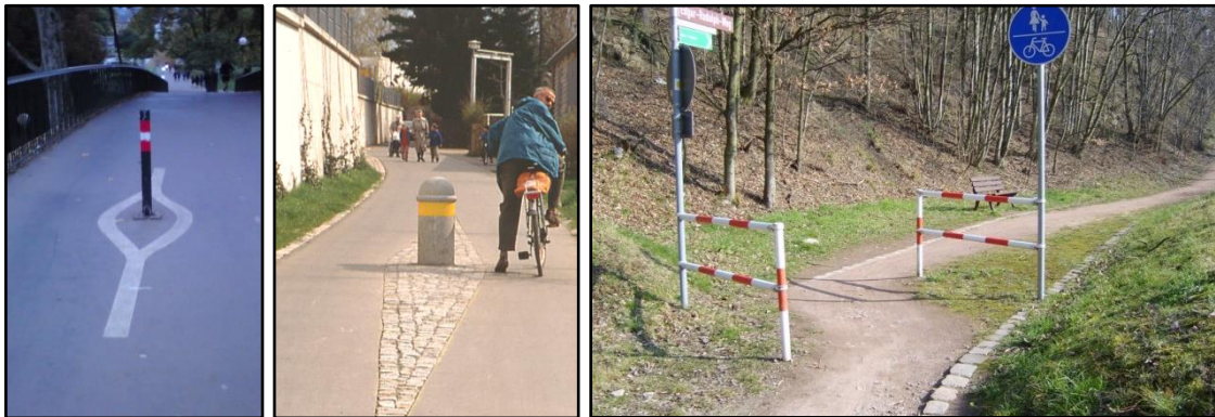
Abb. 43 Beispiele für die Reduzierung von Konfliktpotenzialen an Pollern / Umlaufsperrern
